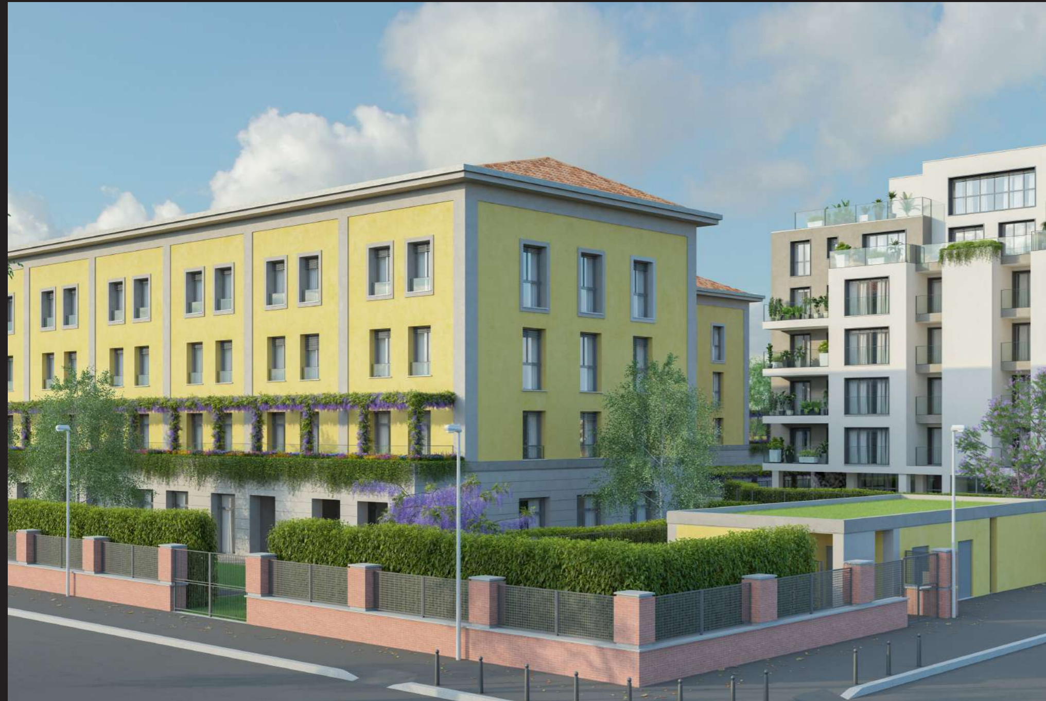
Costruzione RSA e APA - Milano
