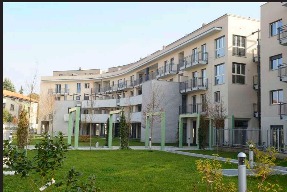
Costruzione di 70 Unità Abitative - Carugo
