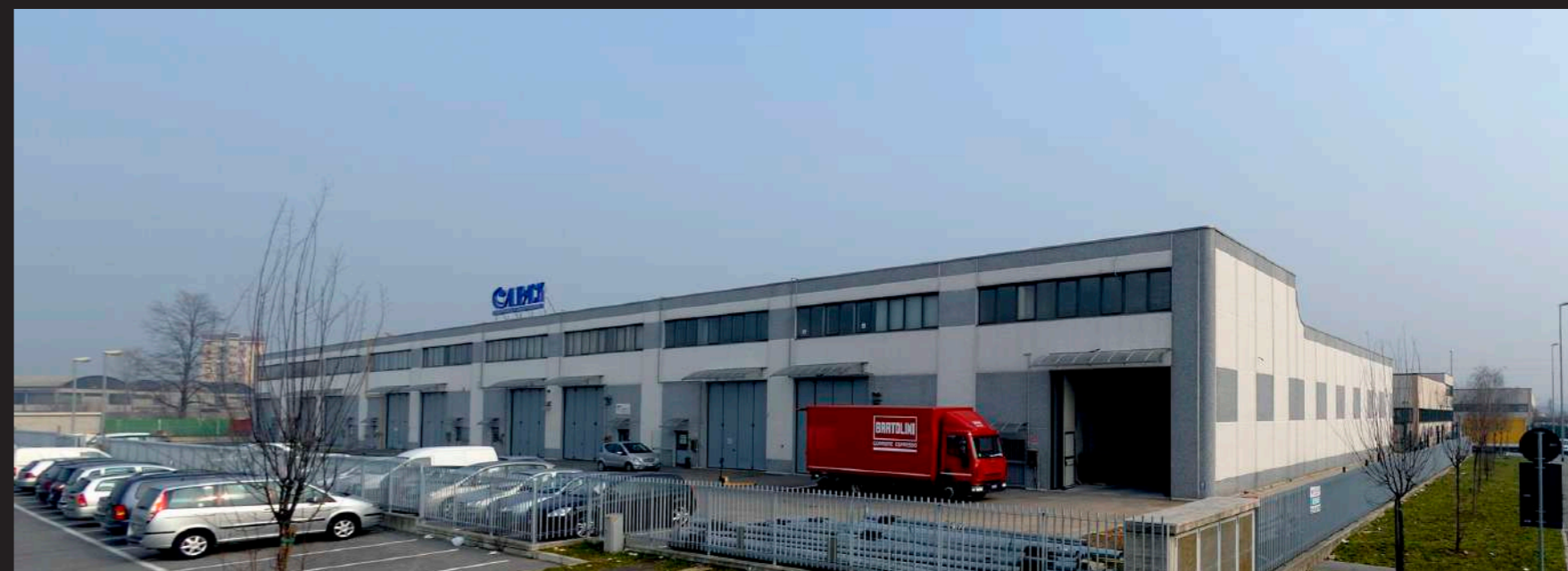
Costruzione edifici commerciali , 5,000 Mq - Cinisello Balsamo
