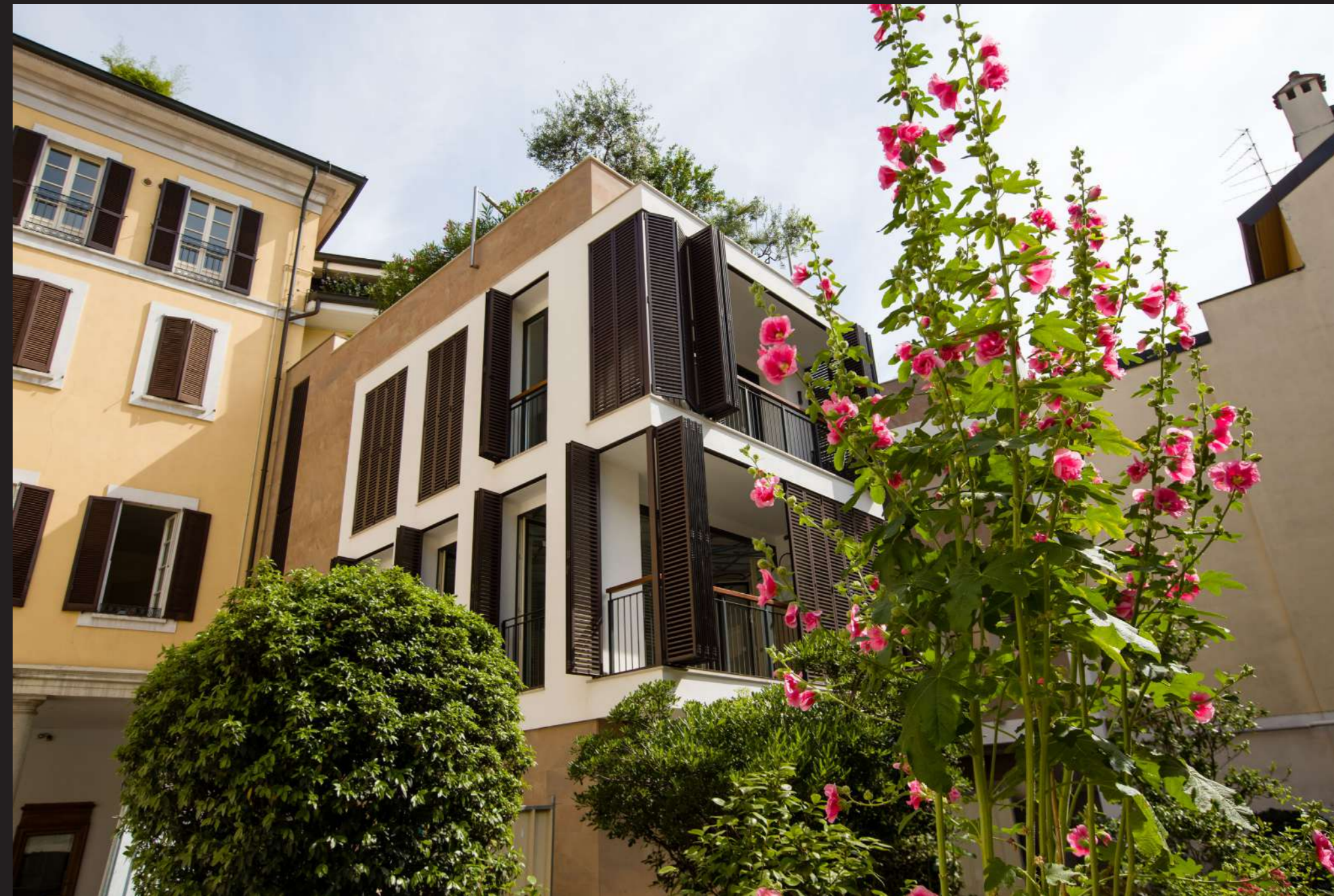
Ristrutturazione palazzina nel centro storico - Milano
