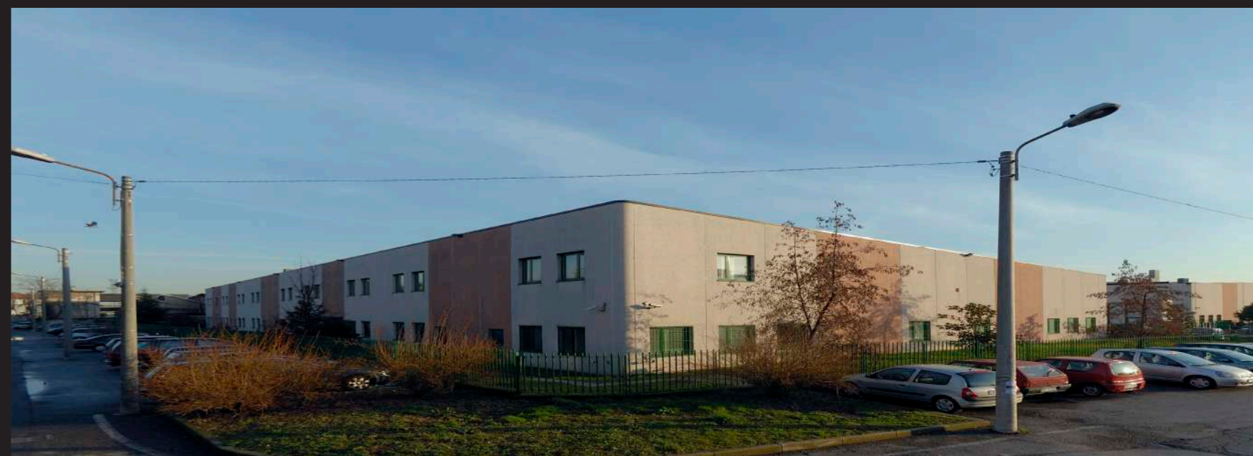
Costruzione capannoni industriali , 10,000 Mq - Villasanta
