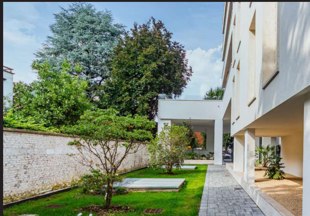
Costruzione abitazioni - Monza - Via Nino Bixio
