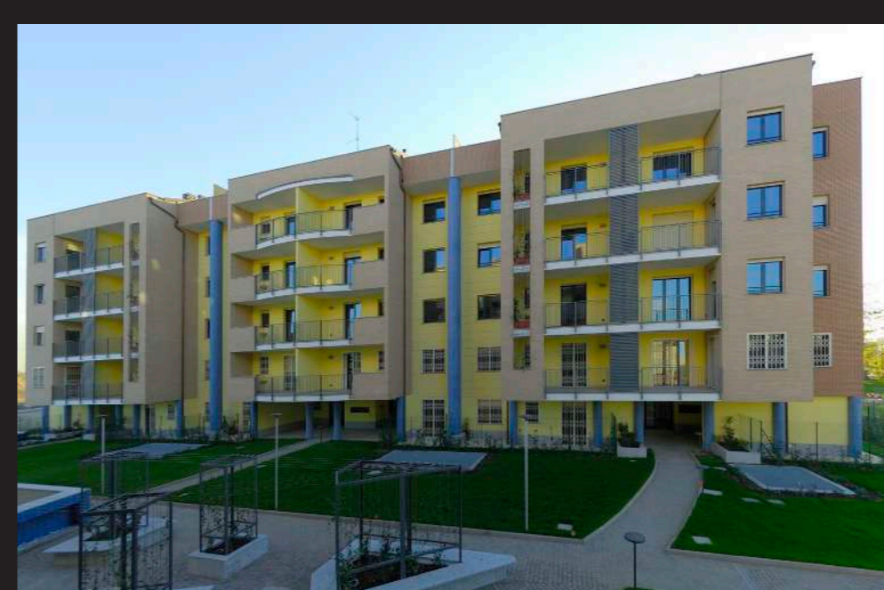
Costruzione di 65 Unità abitative - Pero
