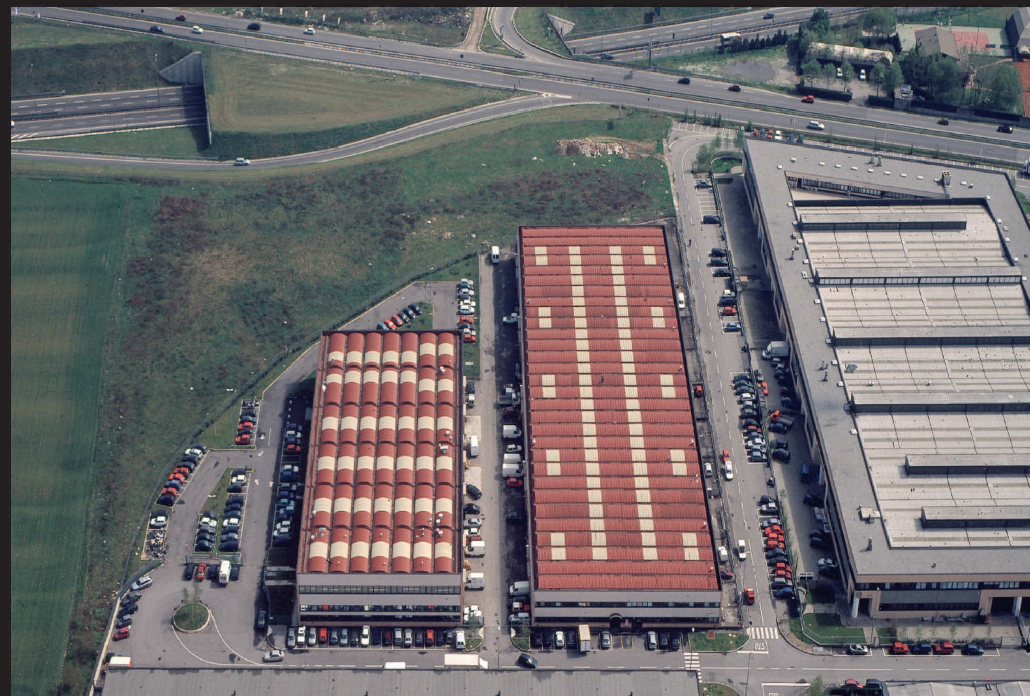
Costruzione di Edifici industriali 30.000 Mq. - Cinisello Balsamo
