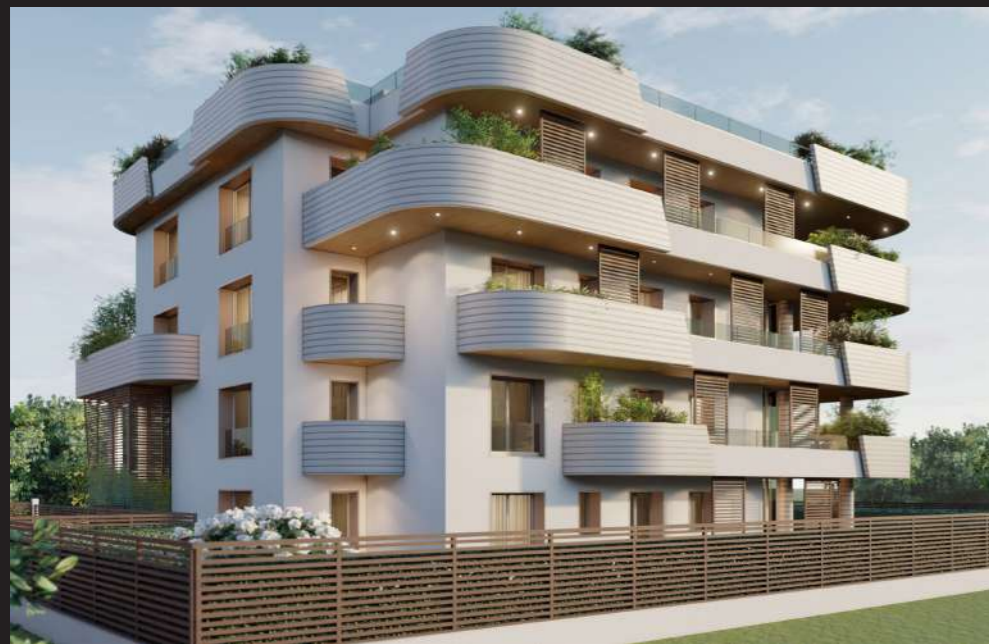
Costruzione abitazioni - Monza - Via Baracca
