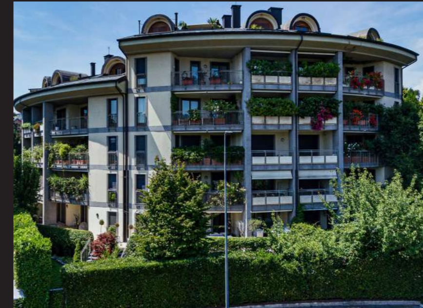
Costruzione di 30 Unità abitative - Milano
