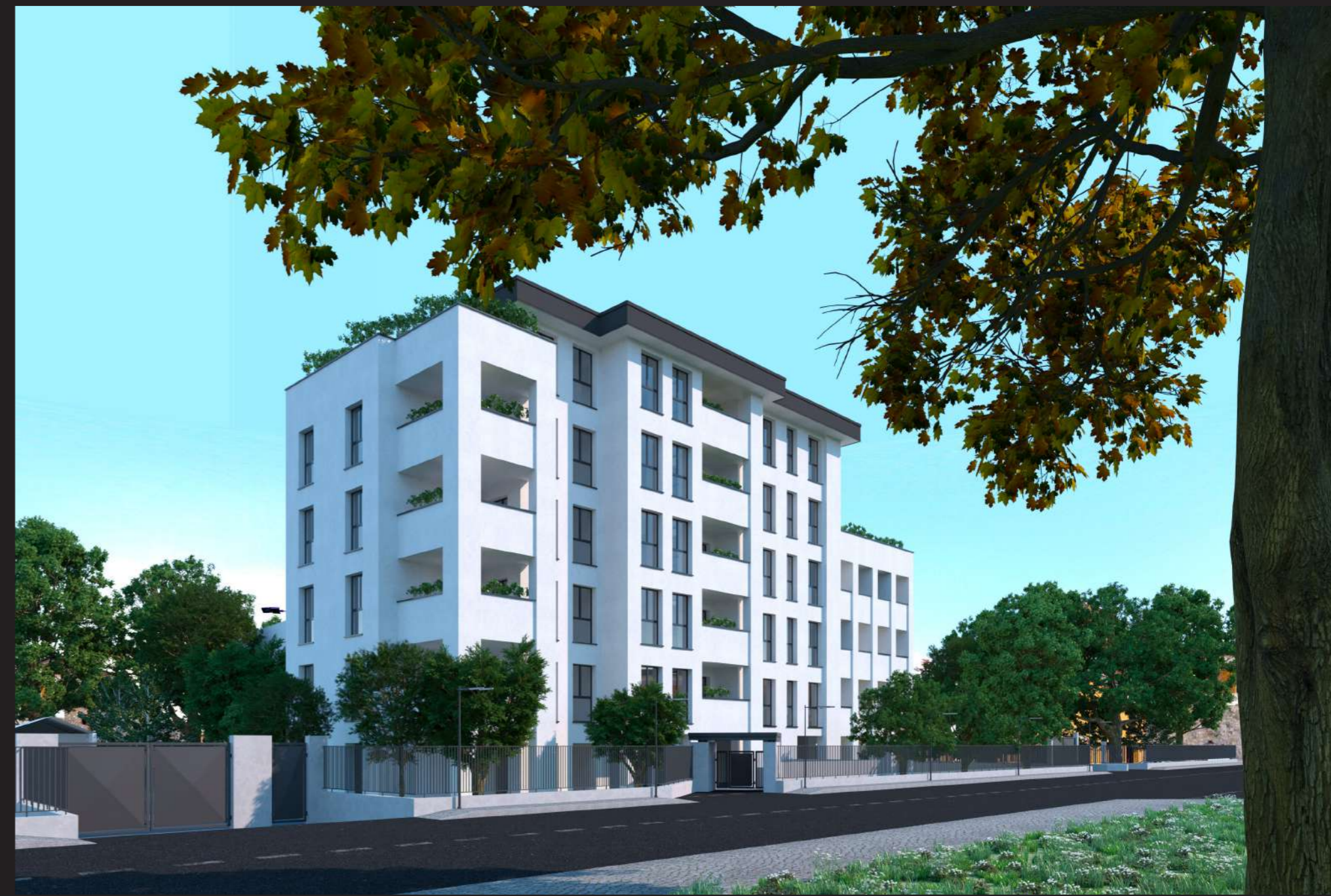
Costruzione abitazioni - Monza - Via Sorteni
