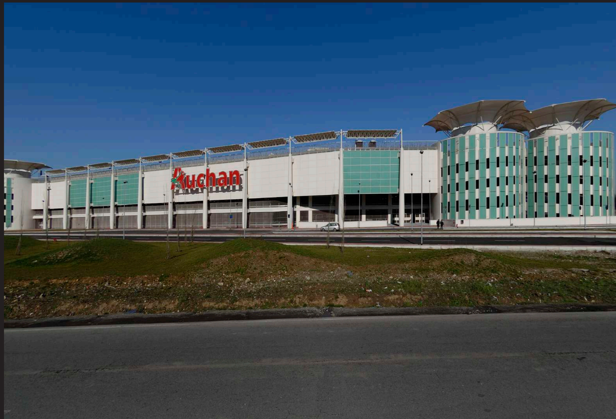
Costruzione di parte del Centro Commerciale Auchan - Cinisello Balsamo
