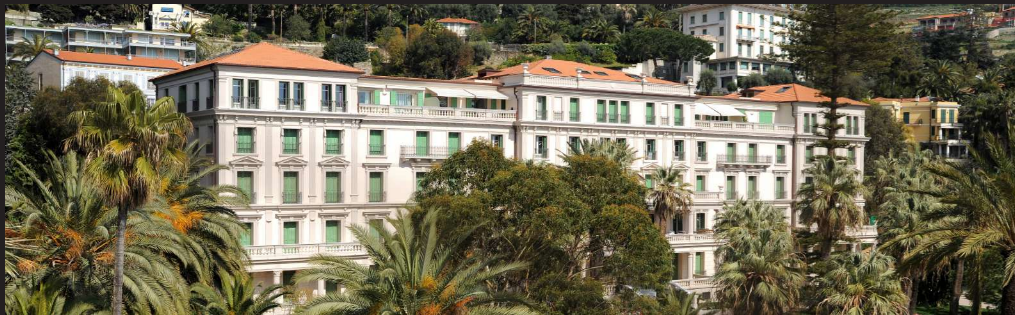
Ristrutturazione di parte di 80 Unità abitative di Grandi dimensioni - Residence regina del Mare - Ospedaletti
