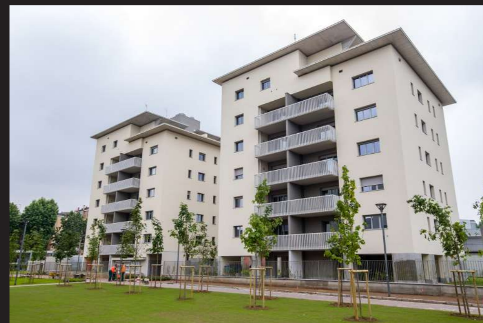
Costruzione di 105 Unità abitative - Cinisello Balsamo
