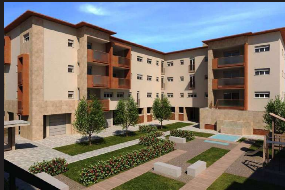
Costruzione di 30 Unità abitative - Pero
