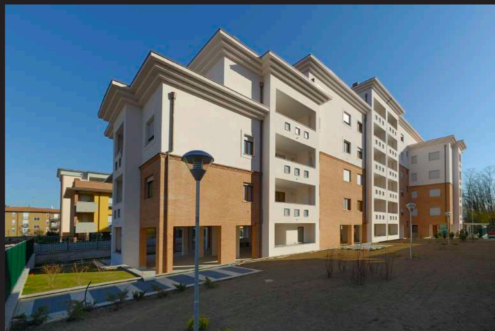
Costruzione di 60 Unità abitative - Legnano
